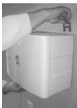
Прижмите агрегат к монтажной пластине. Соедините управляющую контактную пару с ответной частью на монтажной пластине. Удостоверьтесь, что подвесные крюки расположены ровно напротив резиновых уплотнителей на монтажной пластине. Используя ответные части подвесных крюков закрепите агрегат. Подсоедините коннекторы слаботочного кабеля к агрегату.
